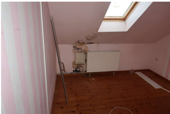
Slika 18: Soba br.1 – potkrovlje – ošt..zida od oborinske vode
