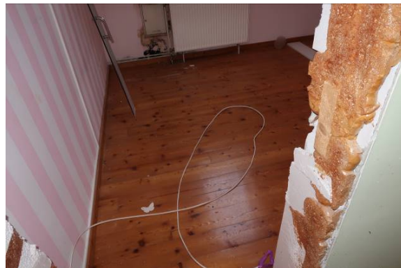
Slika 27: Uklonjena unutarnja stolarija u dijelu prostorija
